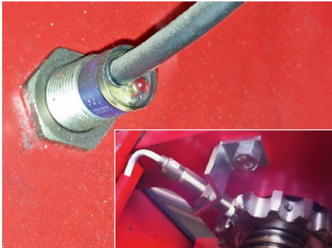
Kontrolle aller Sicherheitseinrichtungen
